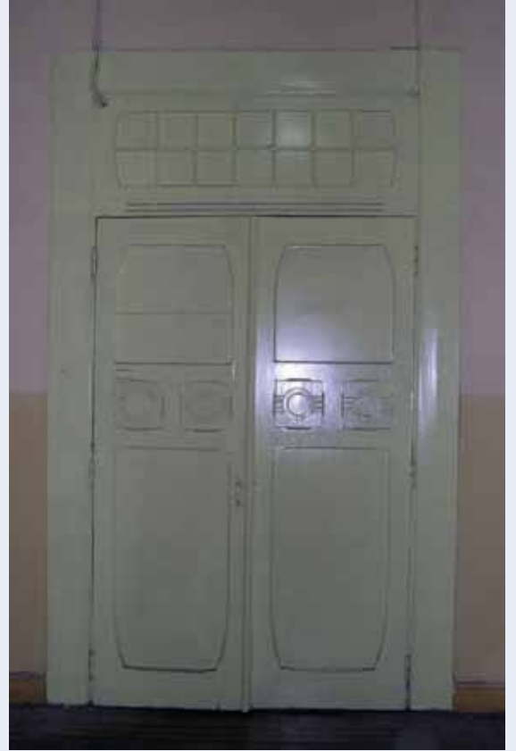
Merdivenlerden hole açılan çift kanatlı kapı.
