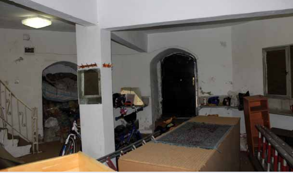
Sunullah Efendi Türbesi, zemin kat sanduka, muhdes betonarme döşeme, kolon ve merdiven.
